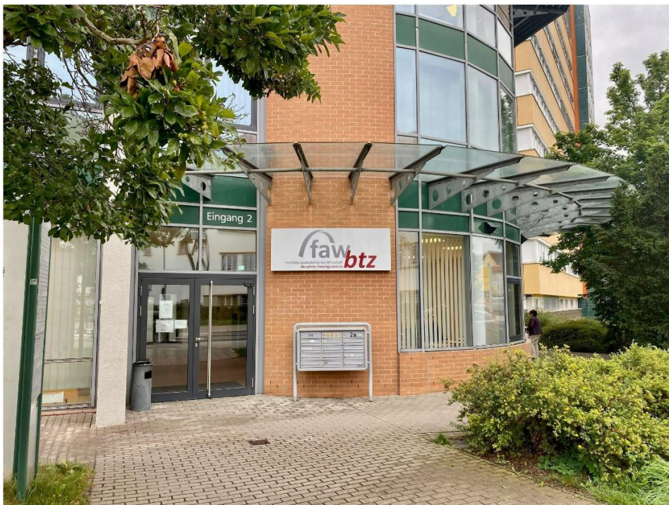
Eingang BTZ vom Kreisverkehr aus
